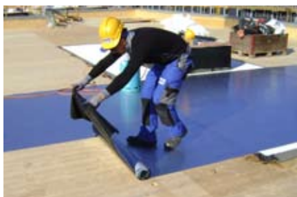
Die Dampfbremse Sarnavap 5000E SA wurde vollflächig aufgeklebt und bietet so eine erste Dichtigkeit für die Holzkonstruktion (Bauzeitabdichtung).
